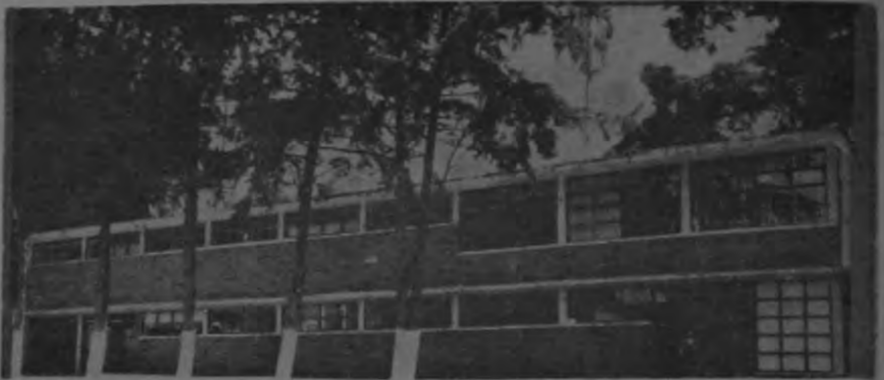
Edificio de la SIECA en Guatemala donde tiene su asiento la Secretaría General del Tratado de Integración Económica Centroamericana.
